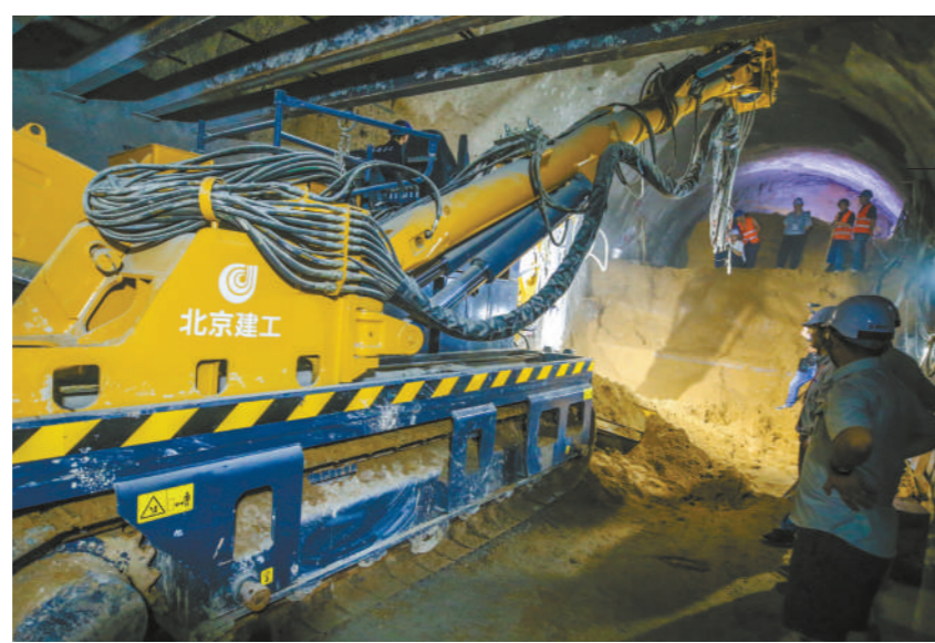
昨天,在东直门桥西北角地下的首都机场线西延施工现场,暗挖台车在隧道内掘进。
