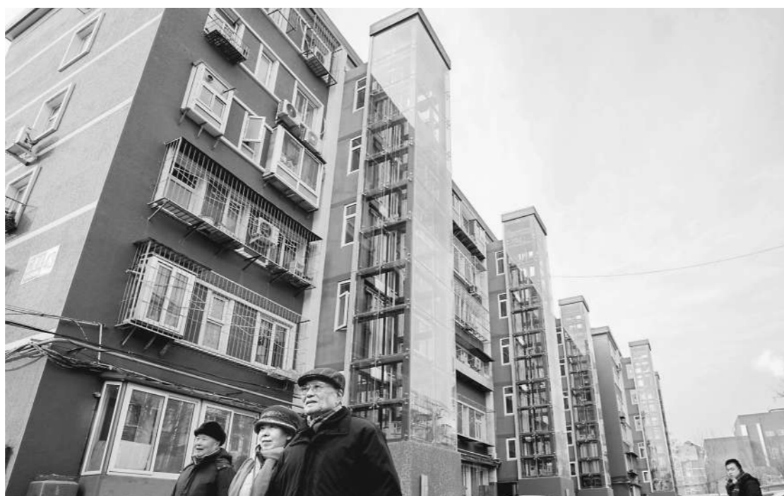
昨天,在海淀区学院路二里庄小区,首批5部电梯已经完成电力增容改造,开始投入使用。
